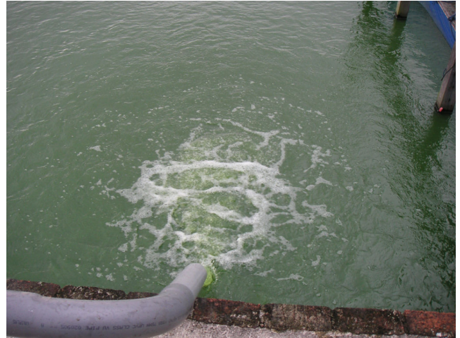
图 3: 在进行 DPA 系统水处理之后，水池的边缘免于水藻积累滋长，水表面呈现更高的透明度。
