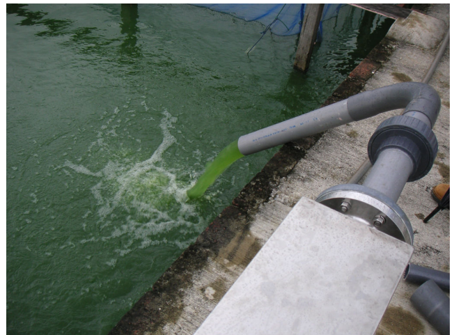
图 4: 图的右方显示在水流系统中被运用的 DPA 无化学水处理系统。
